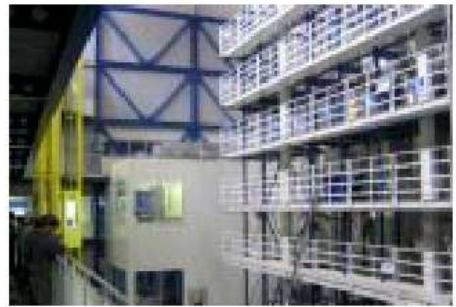
多用途搬出システム (各機械を立体配置した大試験室)
