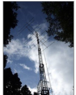
写真右: 野呂山820m山頂の特大アンテナ 地上高27m、144MHz、 総数104エレメント
