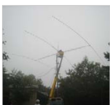
③高所作業車で
