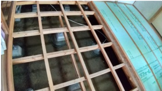
T型鉄鋼束の床下様子
