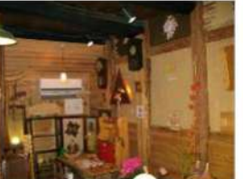
土壁と杉板壁
