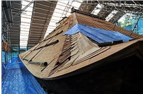
葺き替え中の屋根
