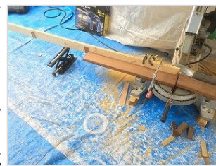
床板4種長切断の 治具と大型丸鋸
