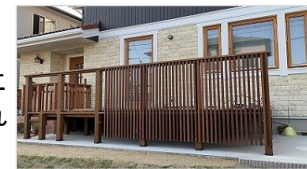
フェンス張り
